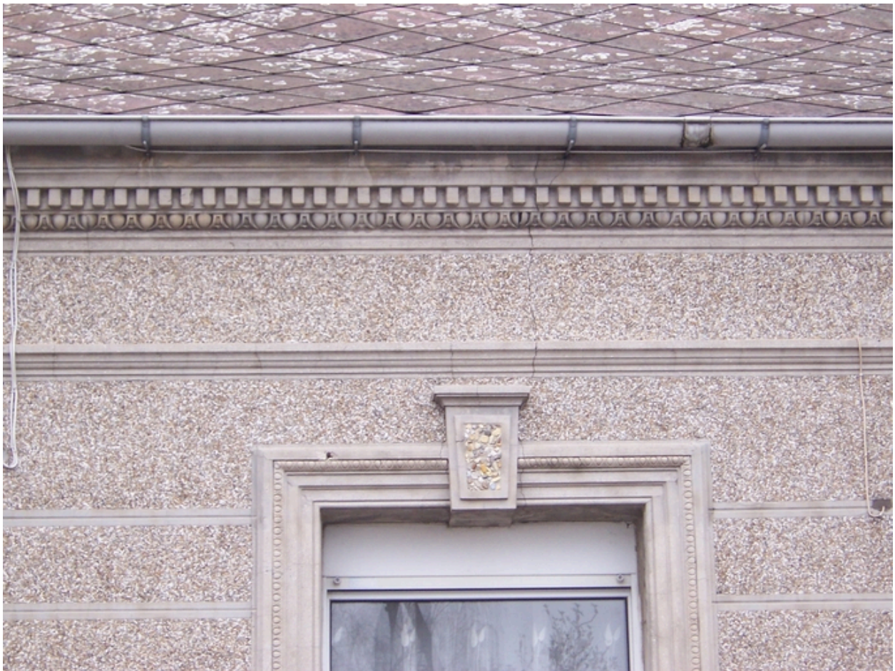
Détail de la façade en gravier roulé.
