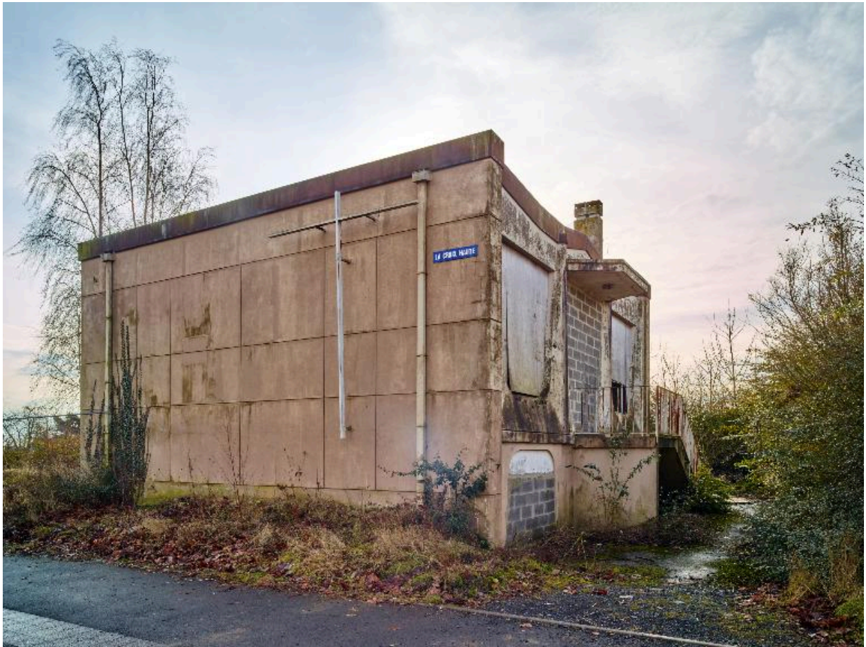
Élévation nord et ouest de l'édifice.
