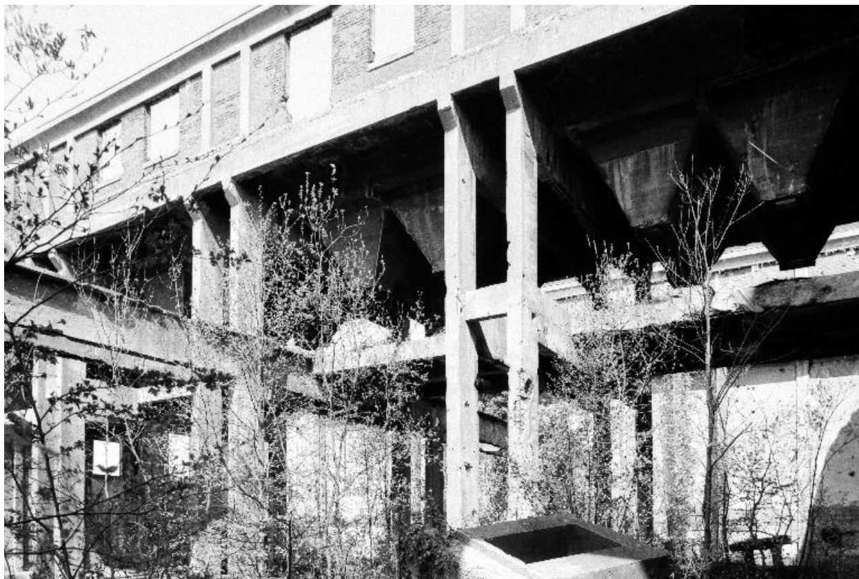
Atelier de fabrication, premier étage, goulottes.
