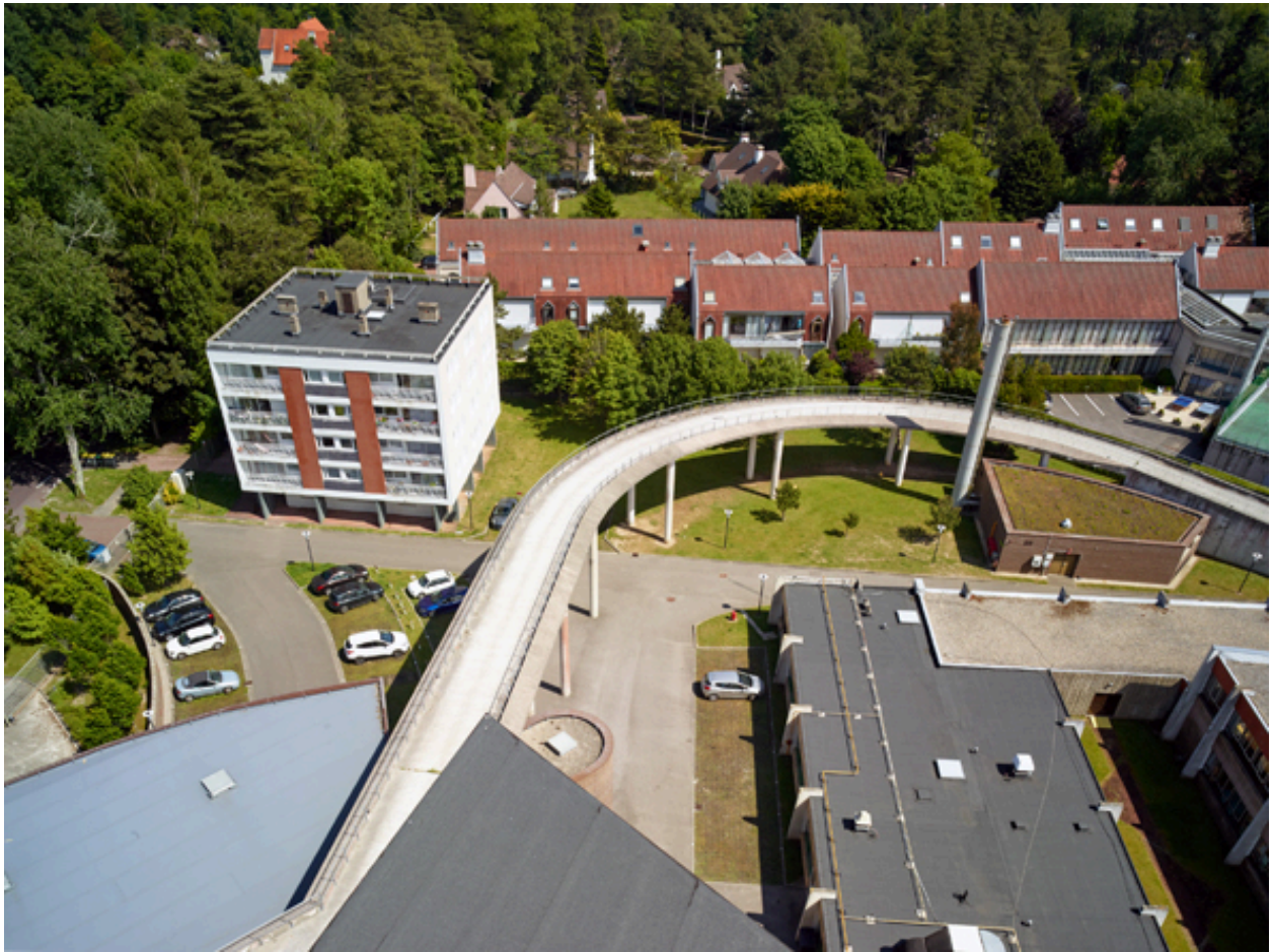
Vue générale de la rampe d'accès et des logements de fonction depuis la toiture de la tour de l'internat.
