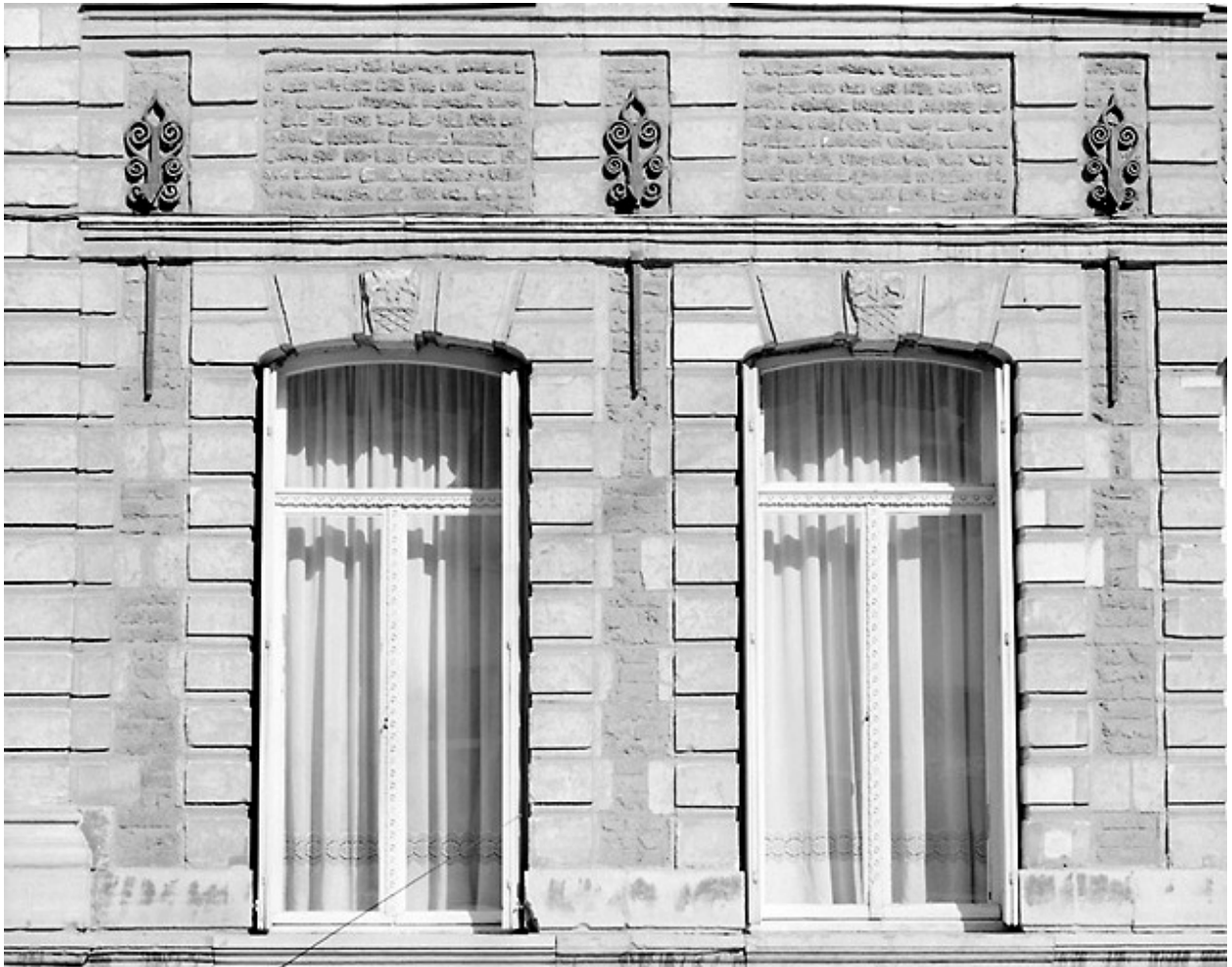
Façade rue Notre-Dame, détail : travées 5 et 6 en partant de la gauche, rez-de-chaussée.
