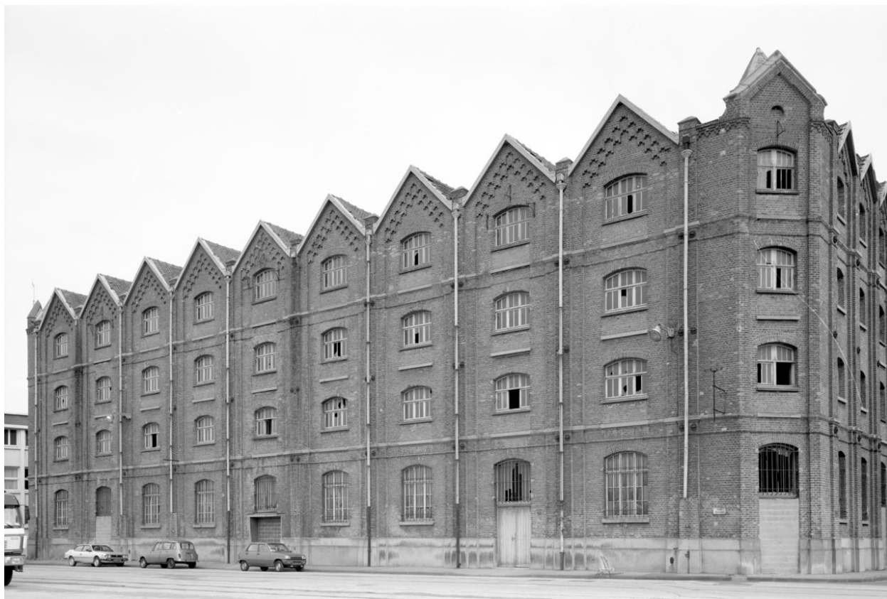
Façade sur quai Freycinet.
