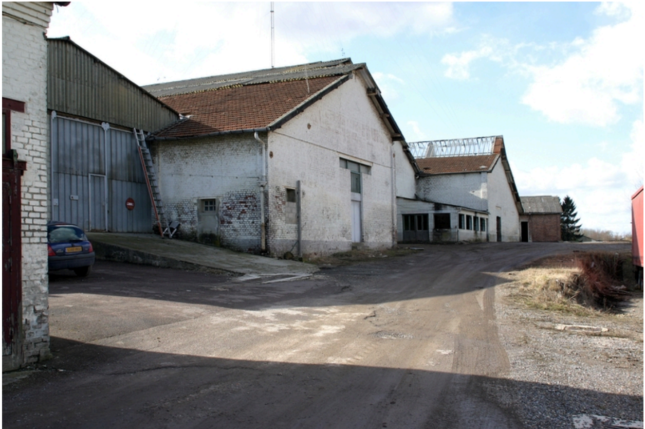
Les ateliers, le magasin industriel (faîtage vitré) et un entrepôt (au fond).
