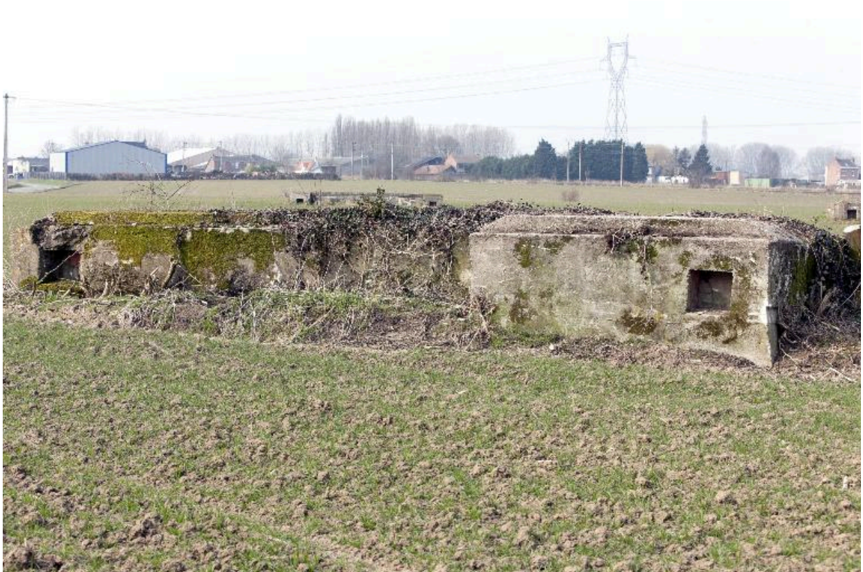
Ouvrage, en L, vers l'ouest
