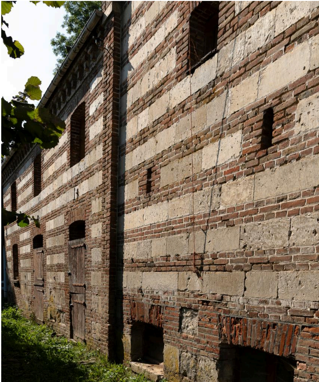
Anciennes étable et écurie vues depuis le nord-est.
