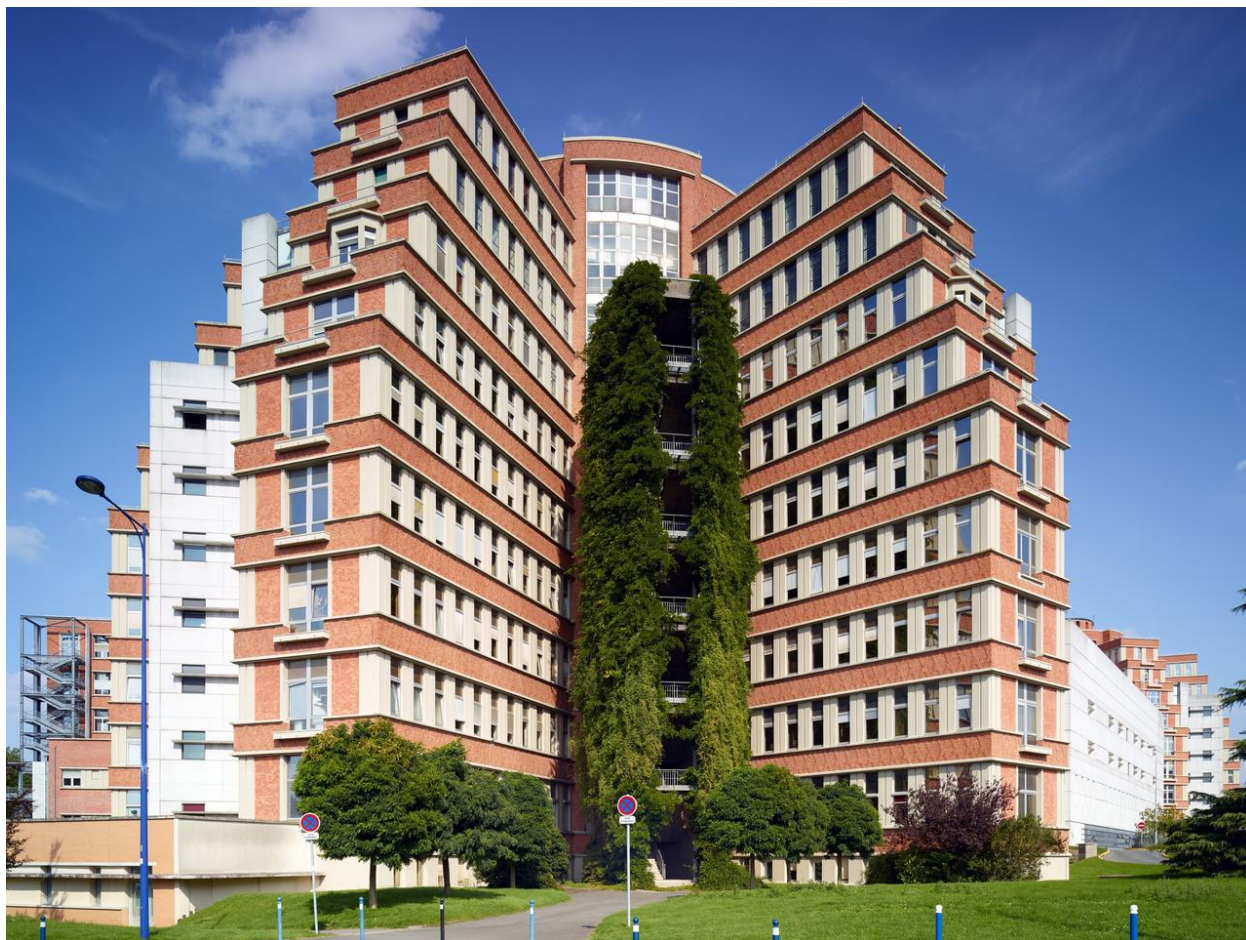
Hôpital, bâtiment d'hospitalisation de plan en étoile sis à l'ouest, vue prise depuis le sud-ouest montrant l'angle de deux des ailes en étoile avec l'escalier de secours végétalisé dans le fond.
