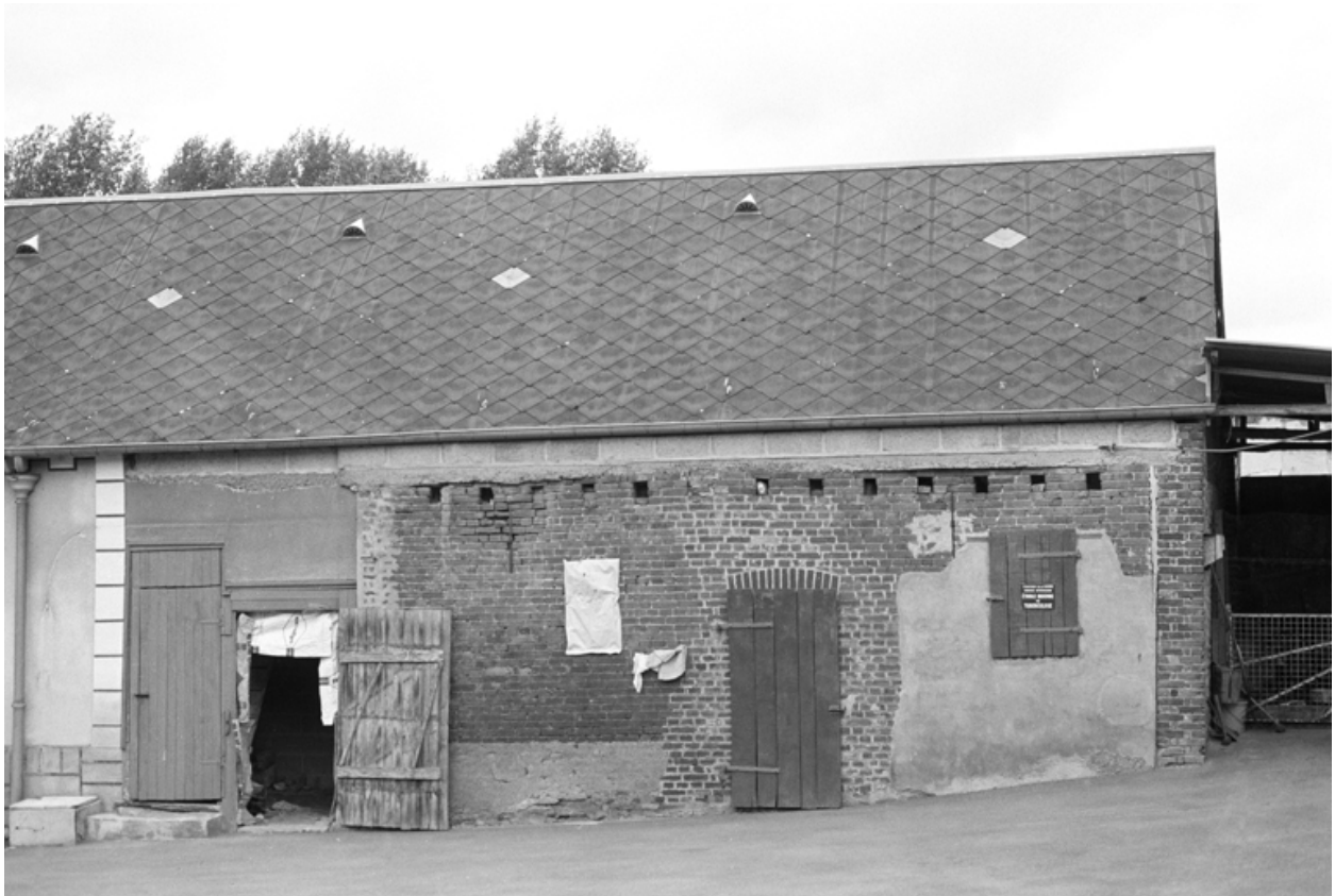
Ecuries sur le côté nord de la cour, mitoyennes avec le logis.
