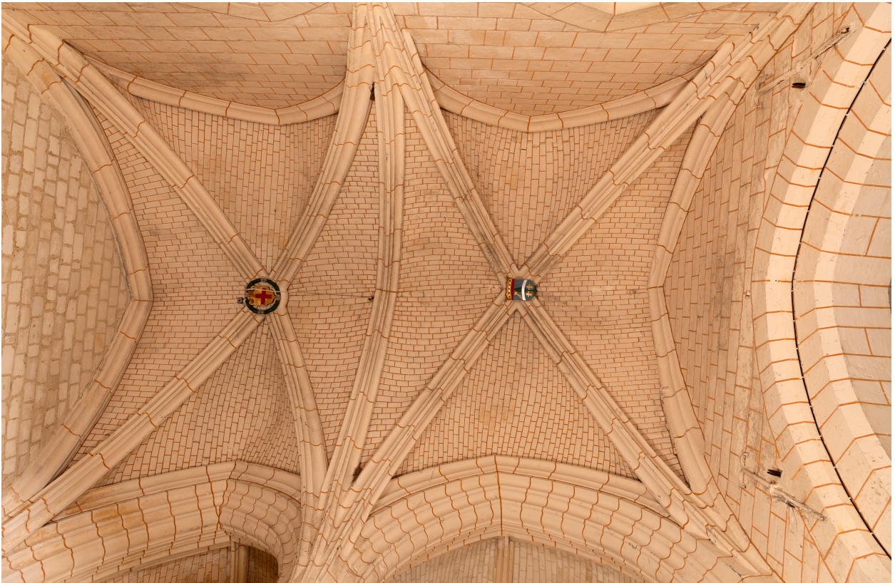
Voûtes du chœur Saint-Nicolas.
