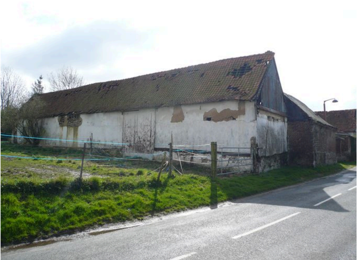
Vue postérieure de la grange depuis la pâture.
