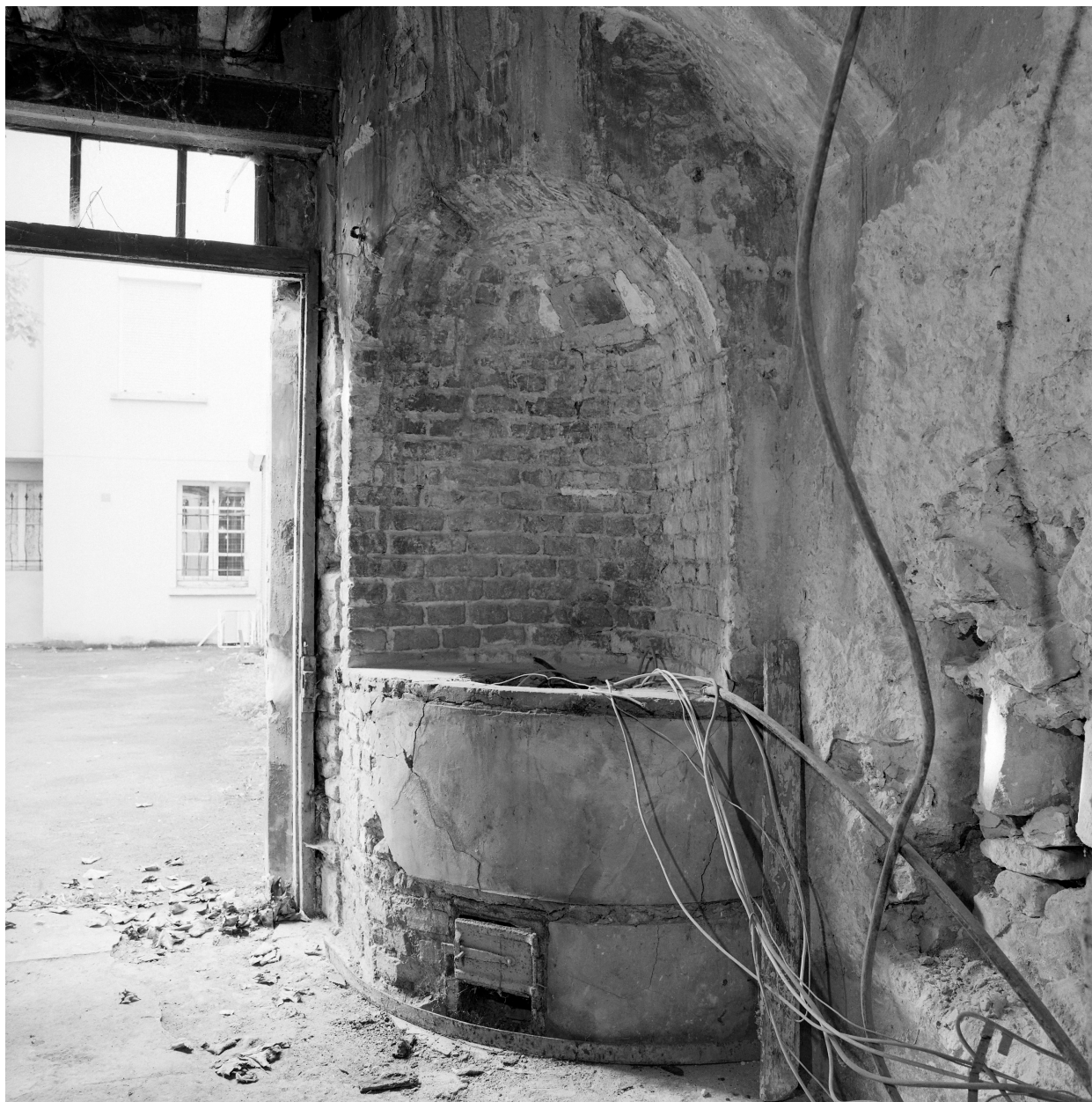
Bâtiment dans la cour 5 rue Henry, rez-de-chaussée, mur nord, foyer.
