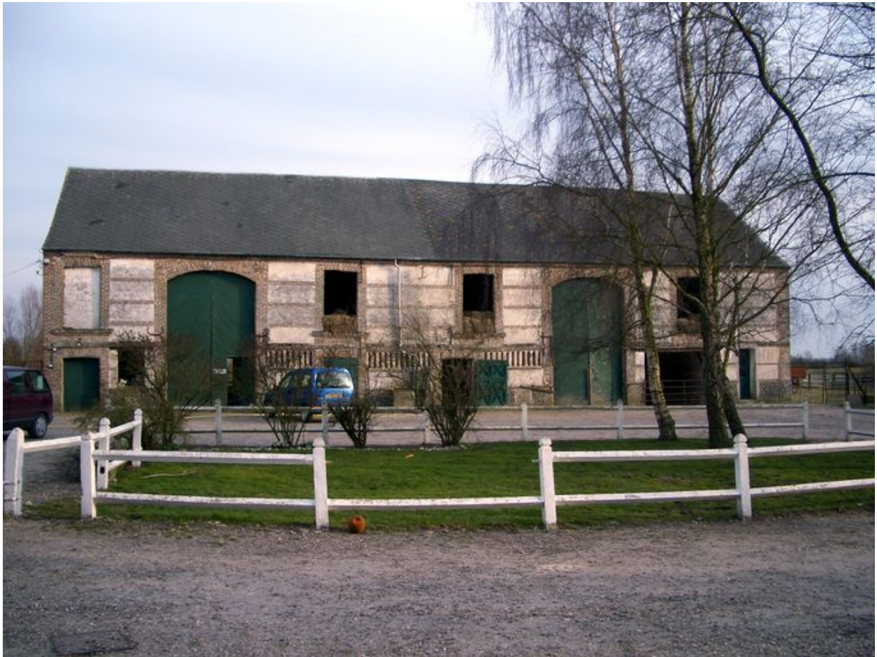
Vue des anciennes étables aujourd'hui transformées en écuries.
