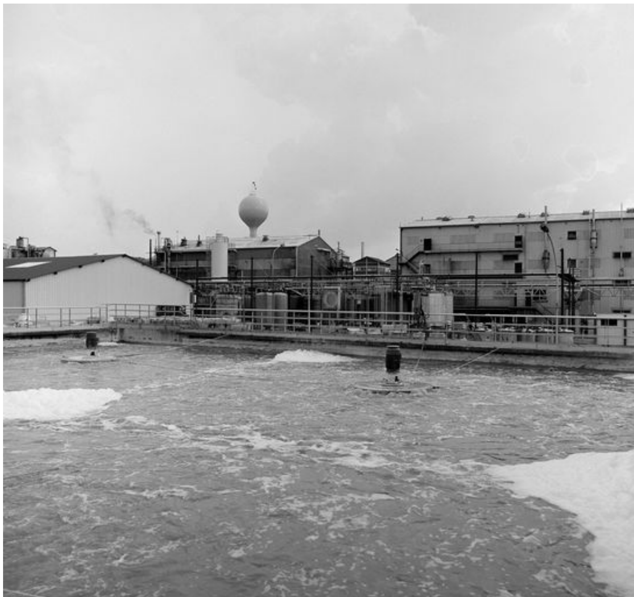
La station d'épuration construite vers 1970.
