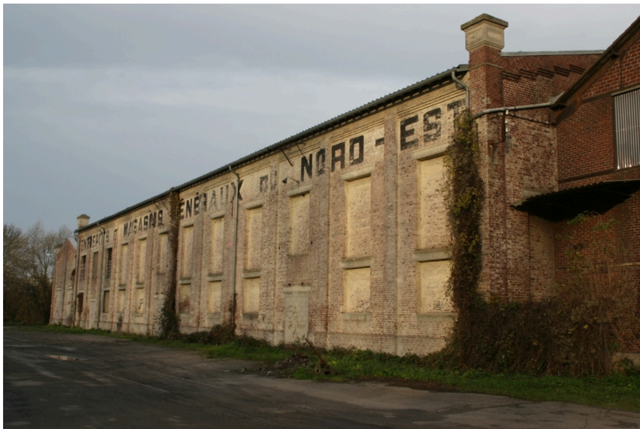
Façade en bordure du canal, détail.
