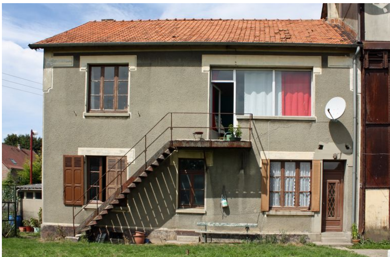
Logement et bureaux, façade postérieure.
