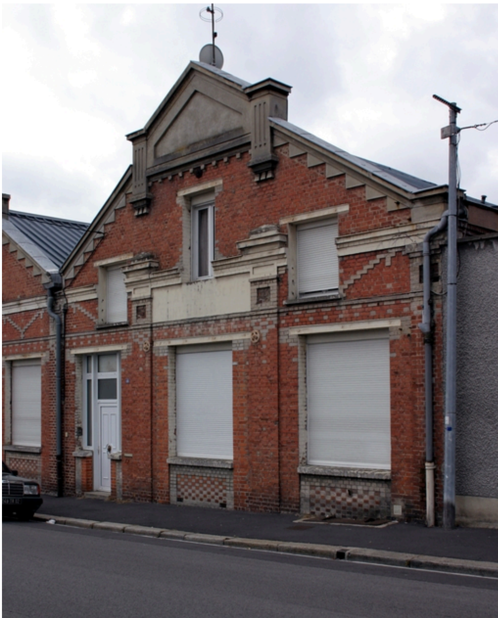
Détail de la façade antérieure des ateliers.
