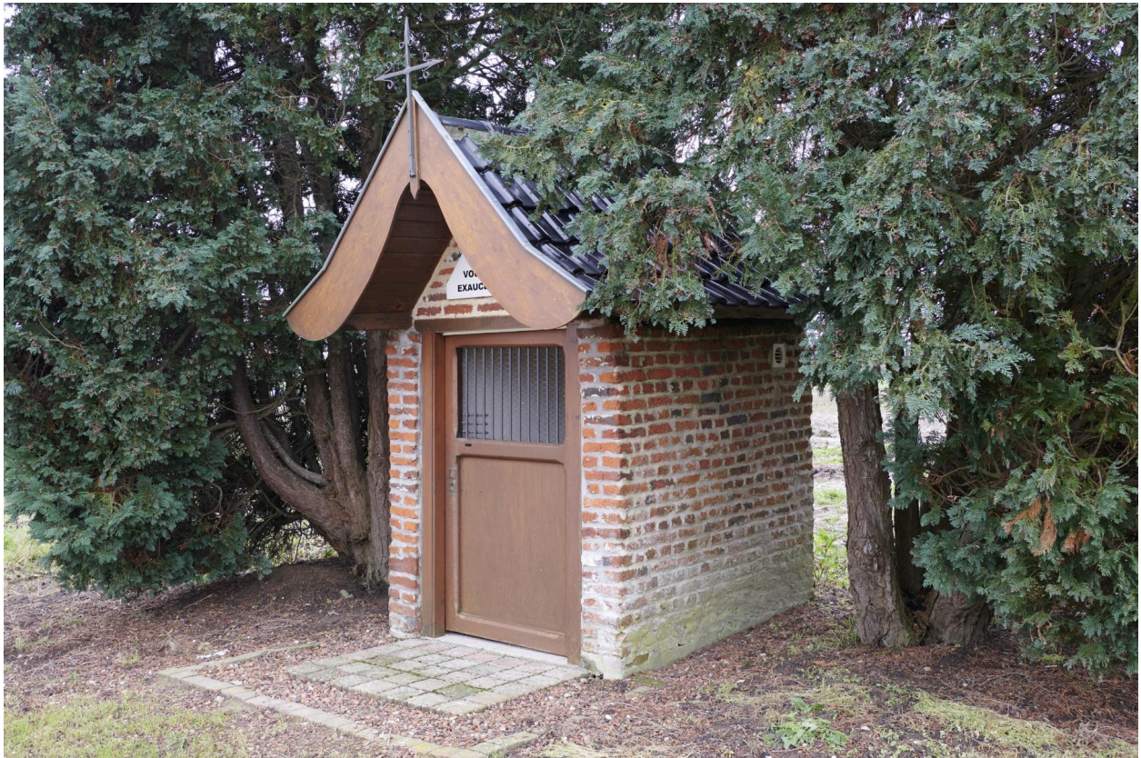
Détail façade et côté droit.
