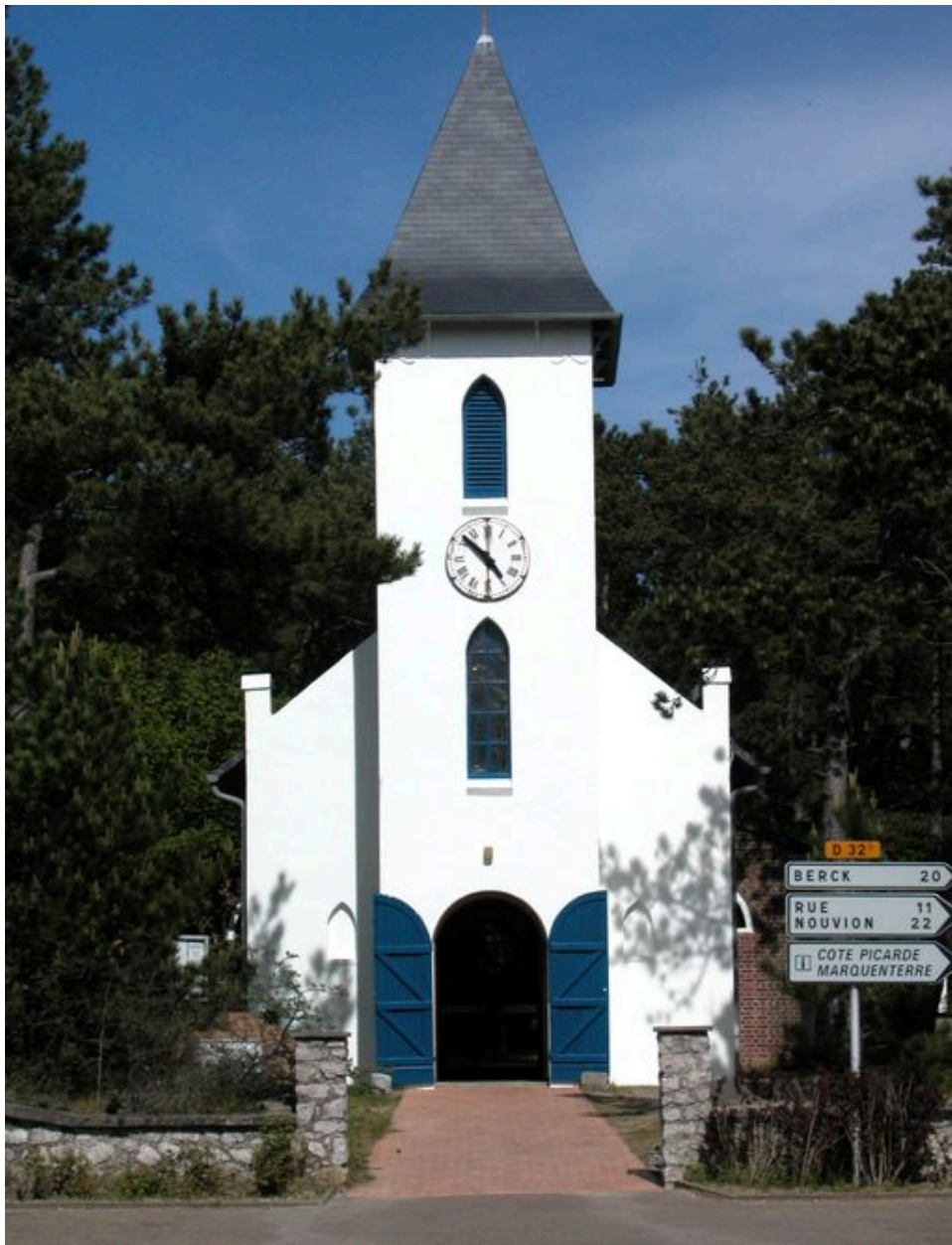
Vue d'ensemble de la façade repeinte.
