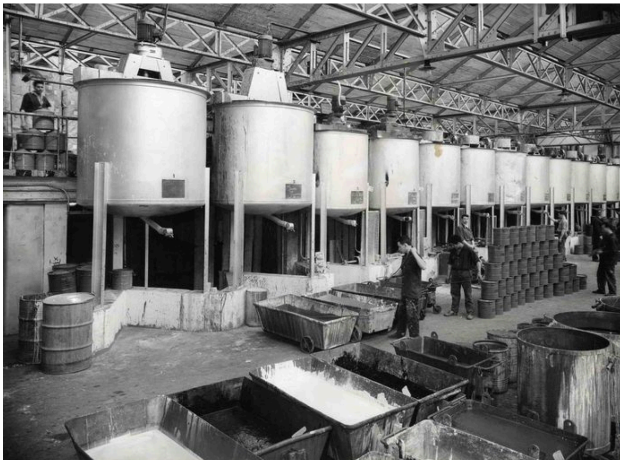
Cuves à mélanges vers 1950 (archives d'entreprise).
