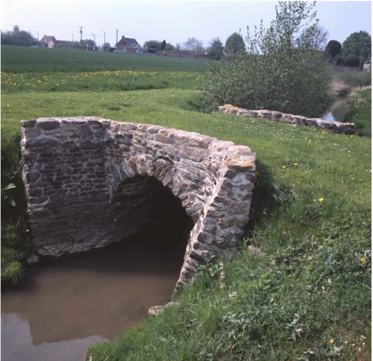
Vue générale du ponceau après restauration.
