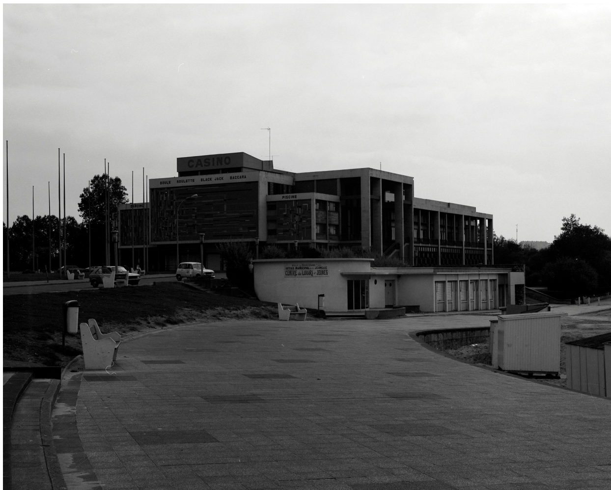
Casino municipal, vue générale d'angle nord.
