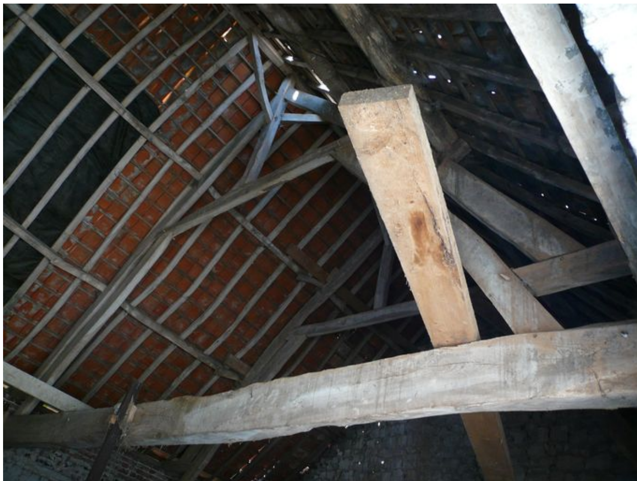
Vue de la charpente de la grange.
