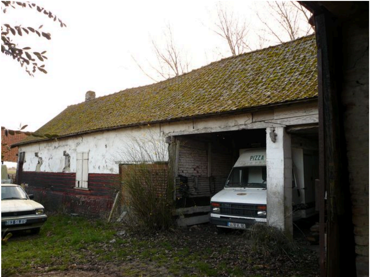
Vue de la maison du vacher depuis la cour.
