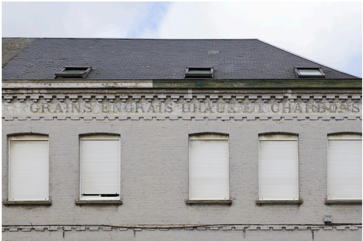
Détails des anciennes inscriptions de la façade sur rue.
