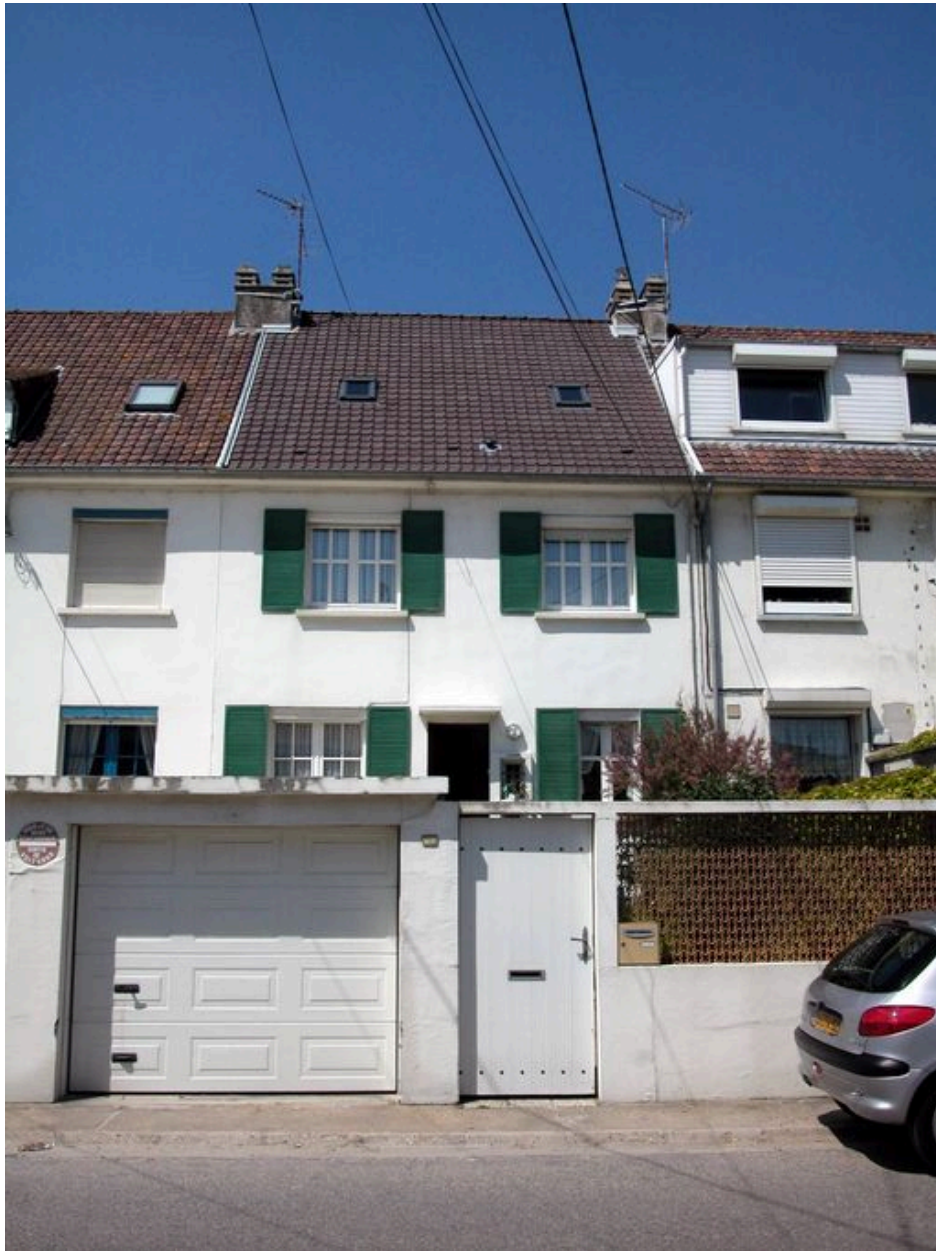
102 boulevard maritime sud (Faraon), façade d'entrée.
