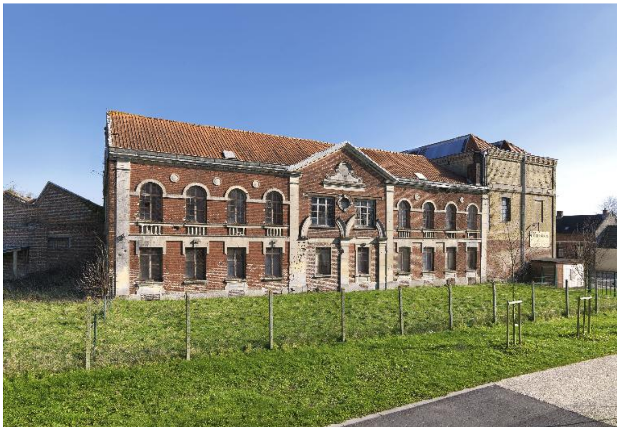
Façade ouest de l'atelier de pliage.
