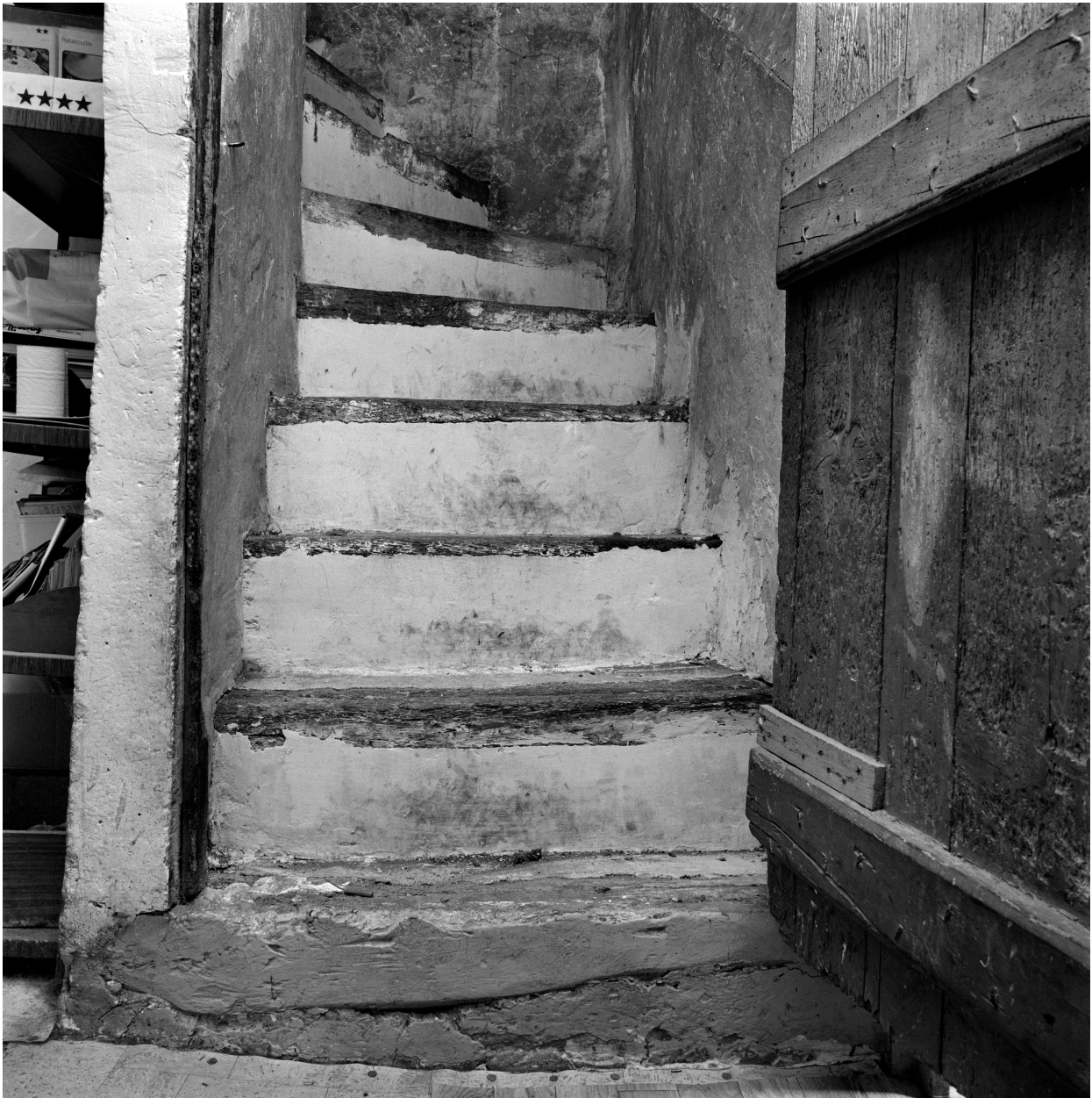
Vue de l'escalier du grenier.
