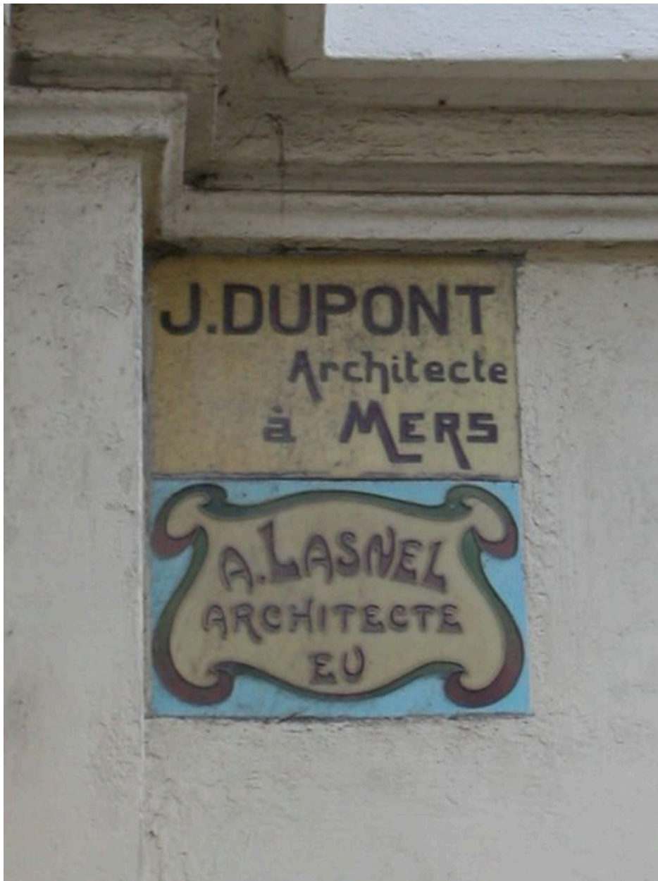
Détail des plaques de céramique portant signature des architectes.
