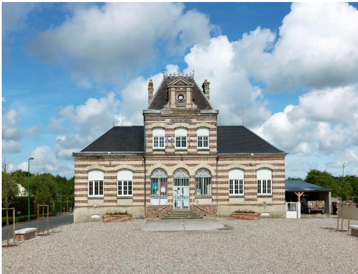
Embreville - Ancienne école, mairie et logement, actuellement mairie et école.
