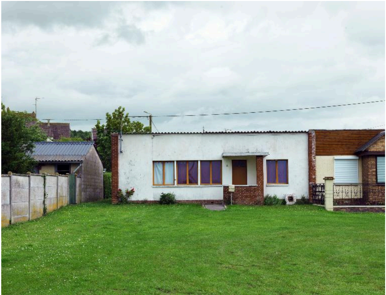
Un des logements de la cité des Castors, vue de face.
