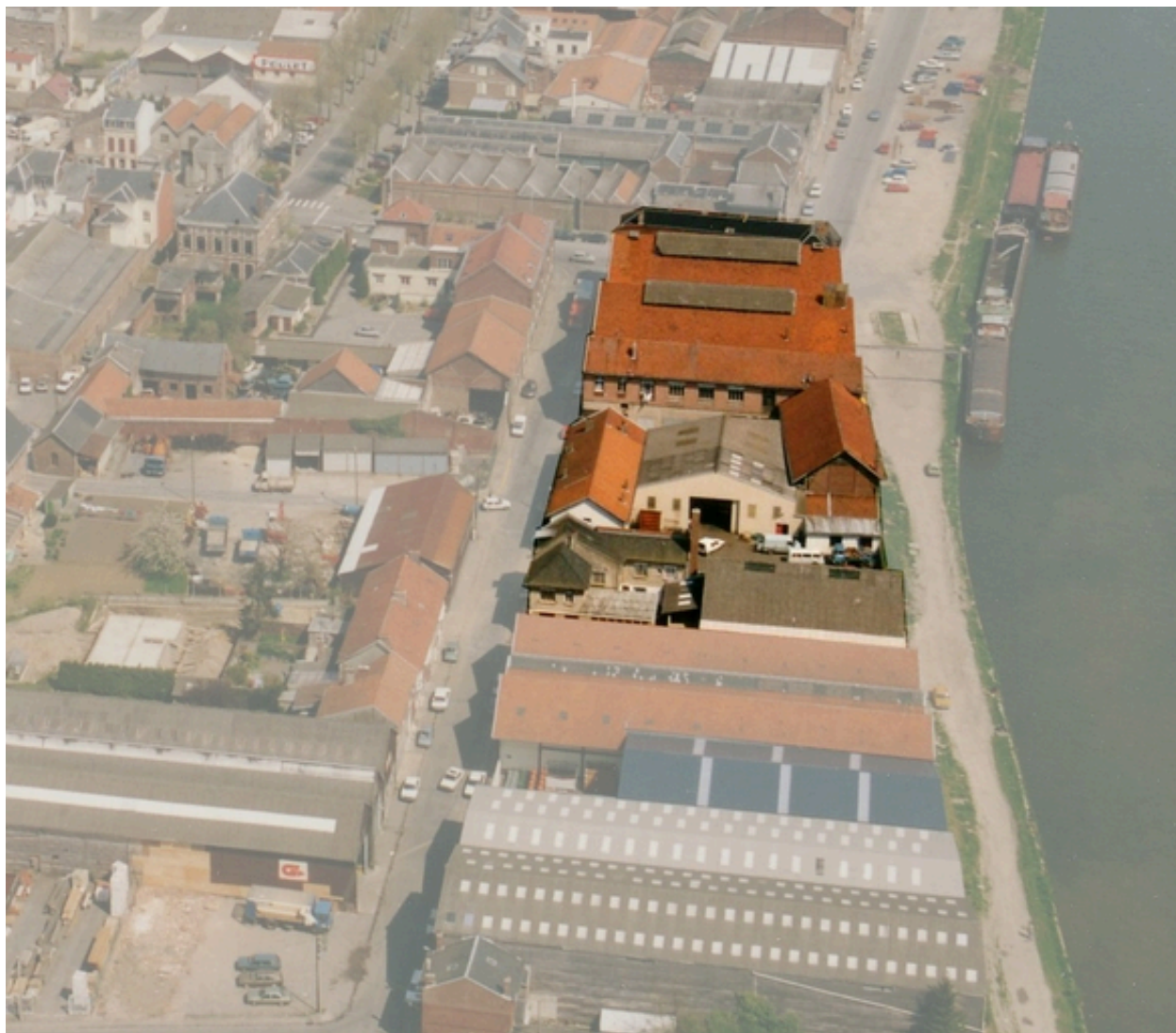
Vue aérienne du site de l'ancien tissage en 1989.
