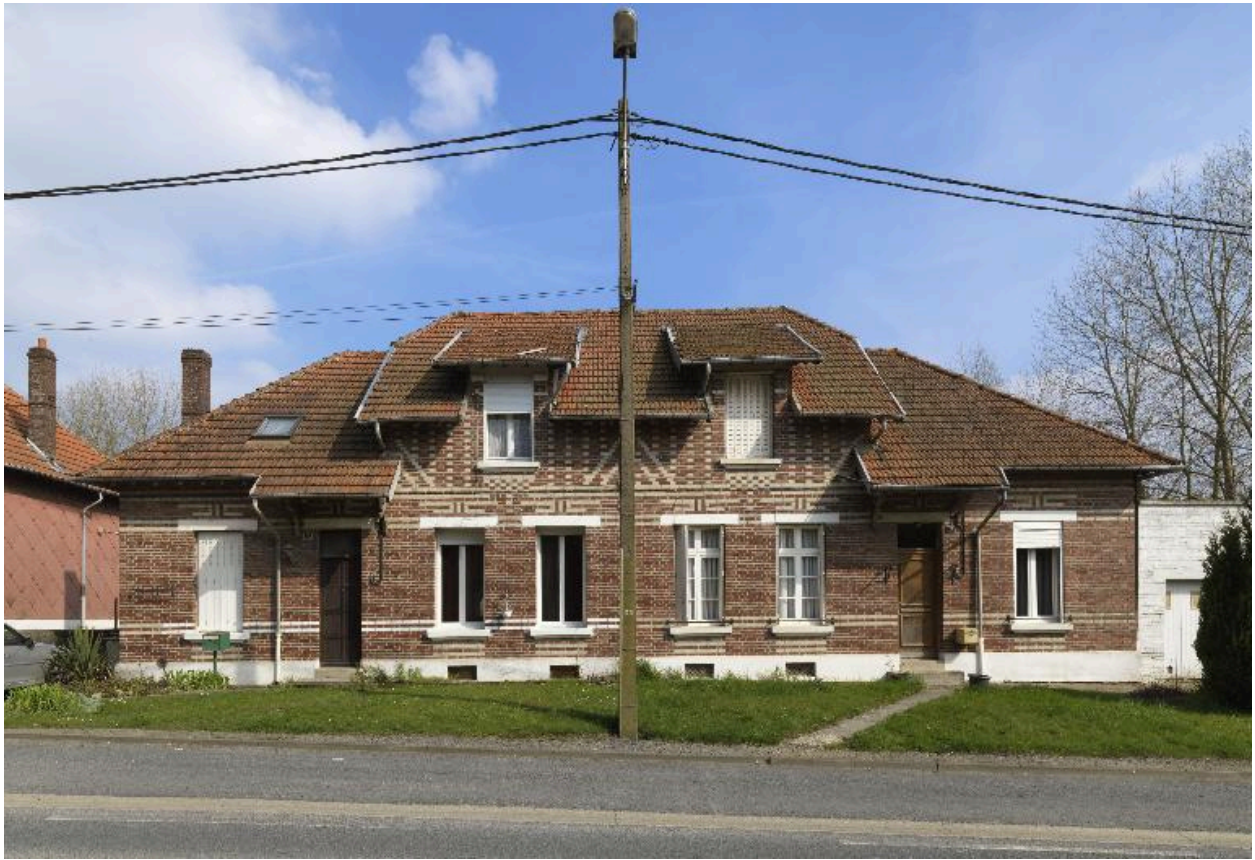
Maison à deux logements (21-22, rue de Roisel).
