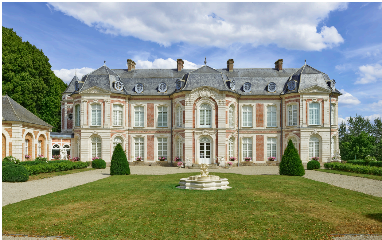
Façade sur cour du château.
