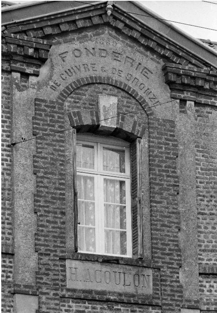
Logement patronal, détail, en 1990.
