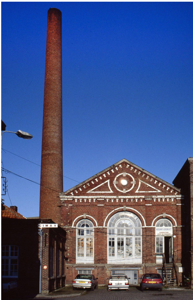
Seconde salle des machines. Élévation antérieure.
