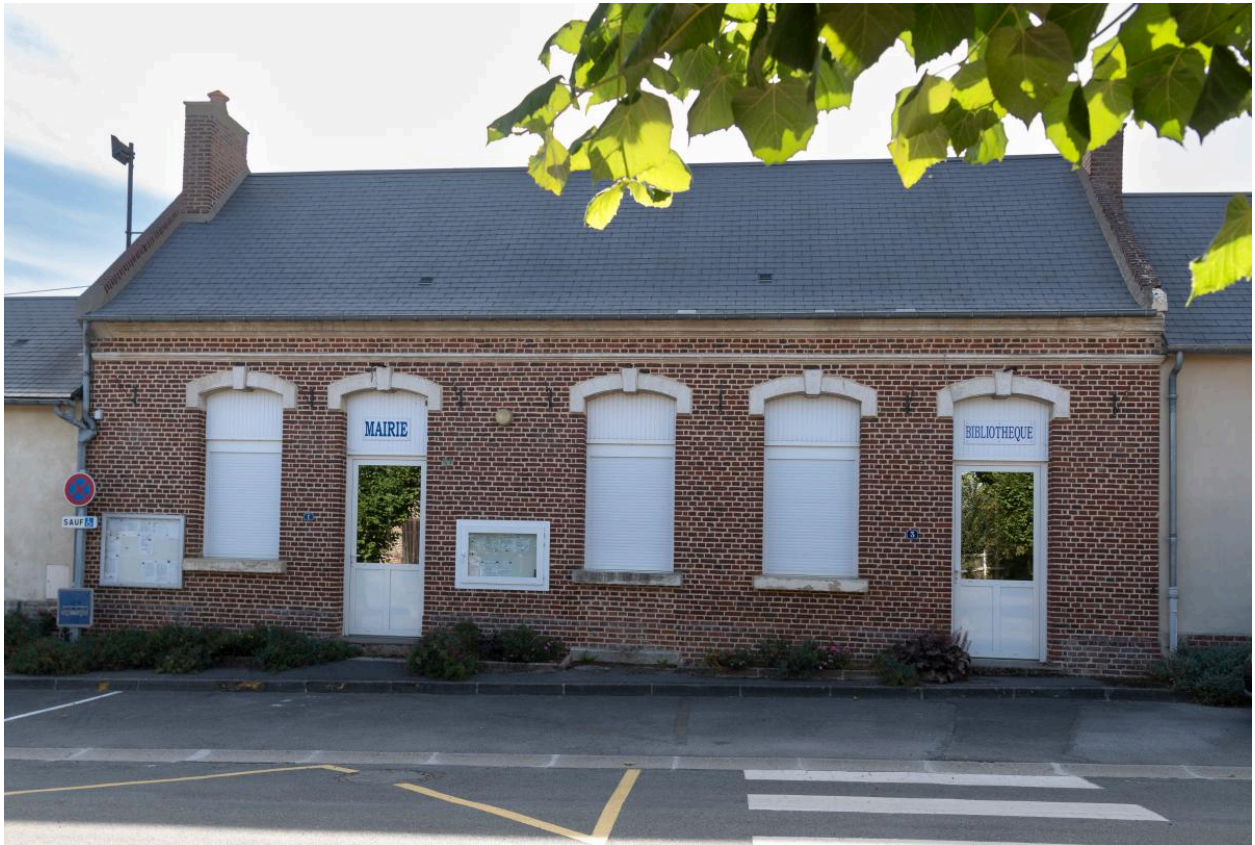
Mairie-école, vue depuis le nord-ouest.
