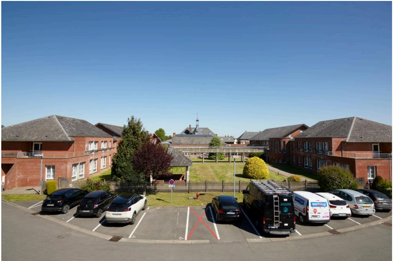
Vue générale de l'intérieur du site depuis le bâtiment de la lingerie.
