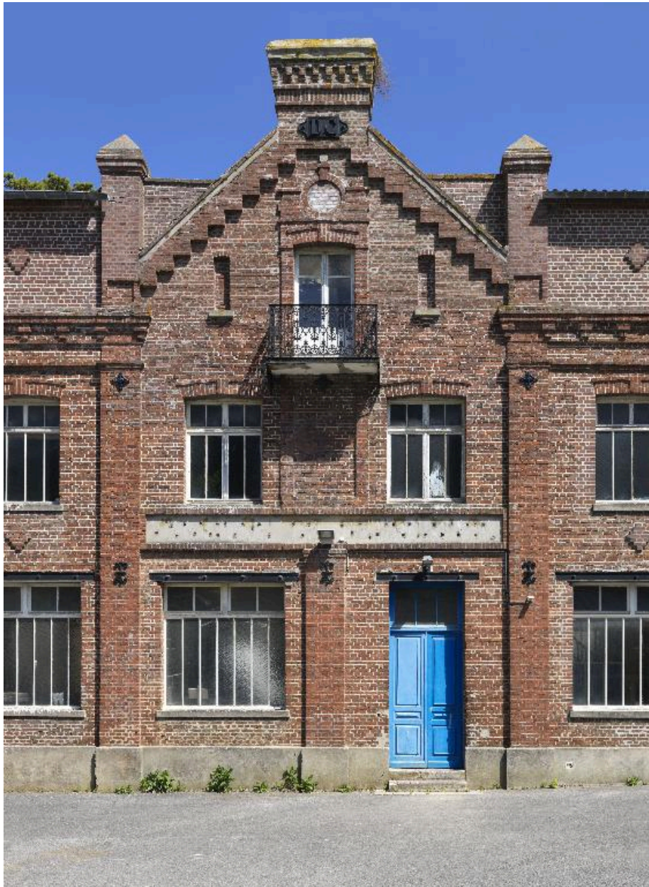
Détail des travées centrales de l'atelier principal.
