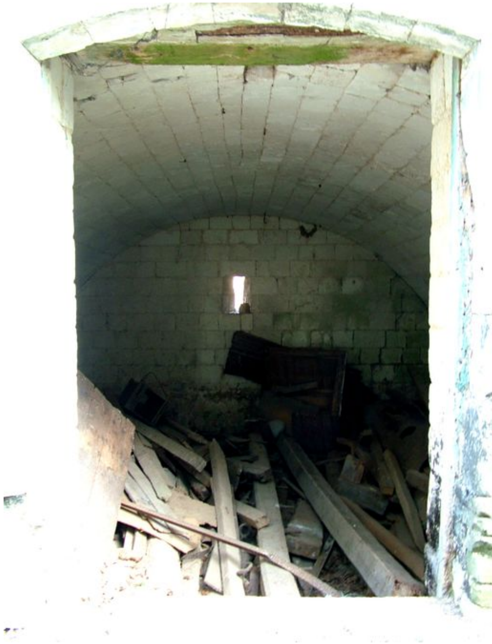
Porte et voûte en berceau du cellier dans le soubassement du colombier.
