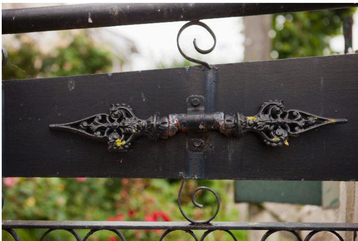
Portail sur rue, détail.
