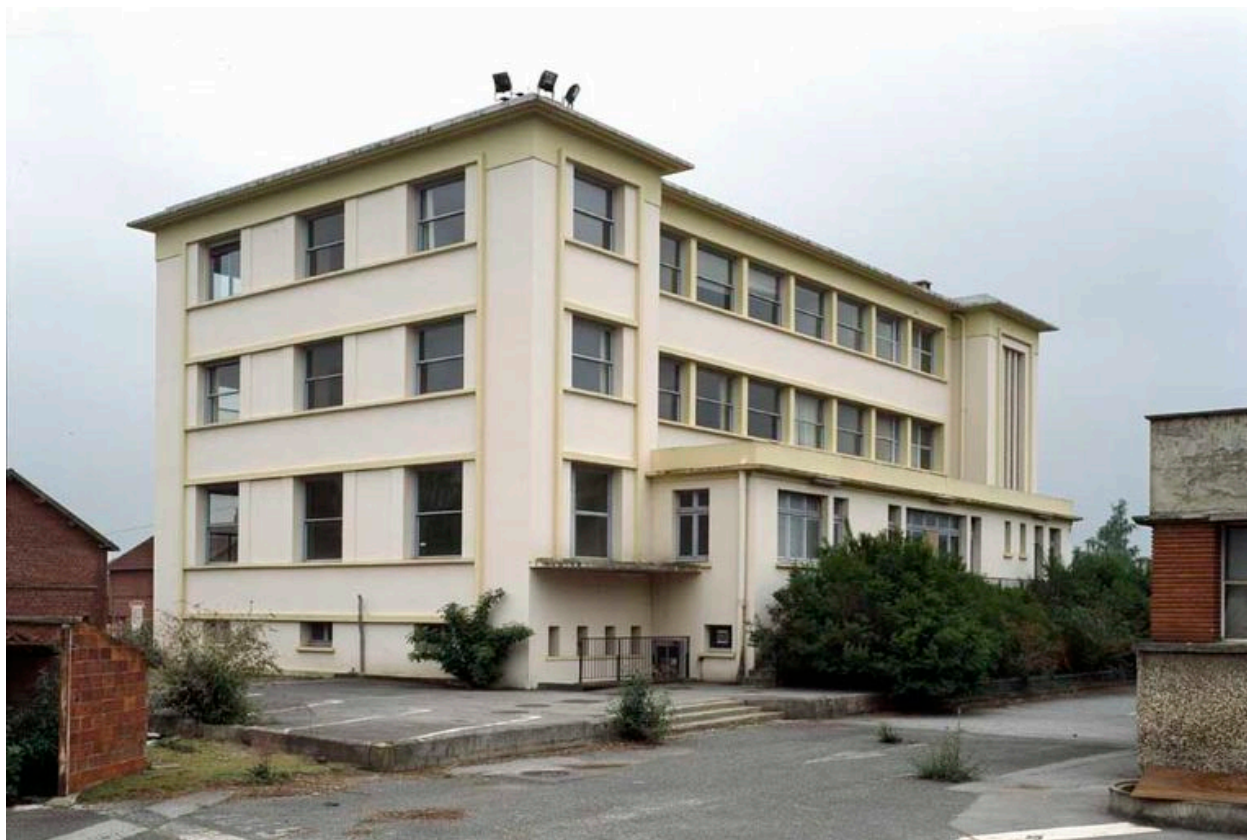
Façades nord-est du bâtiment administratif et social.
