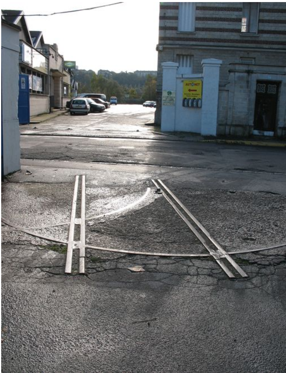
Arrivée de l'embranchement ferroviaire dans la cour de stockage du matériel.
