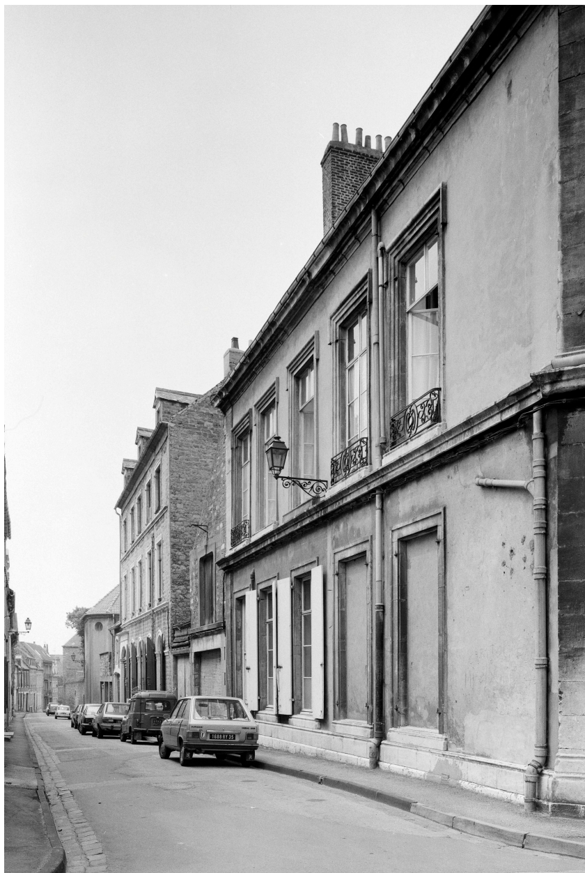
Façade, rue de l'Oratoire.
