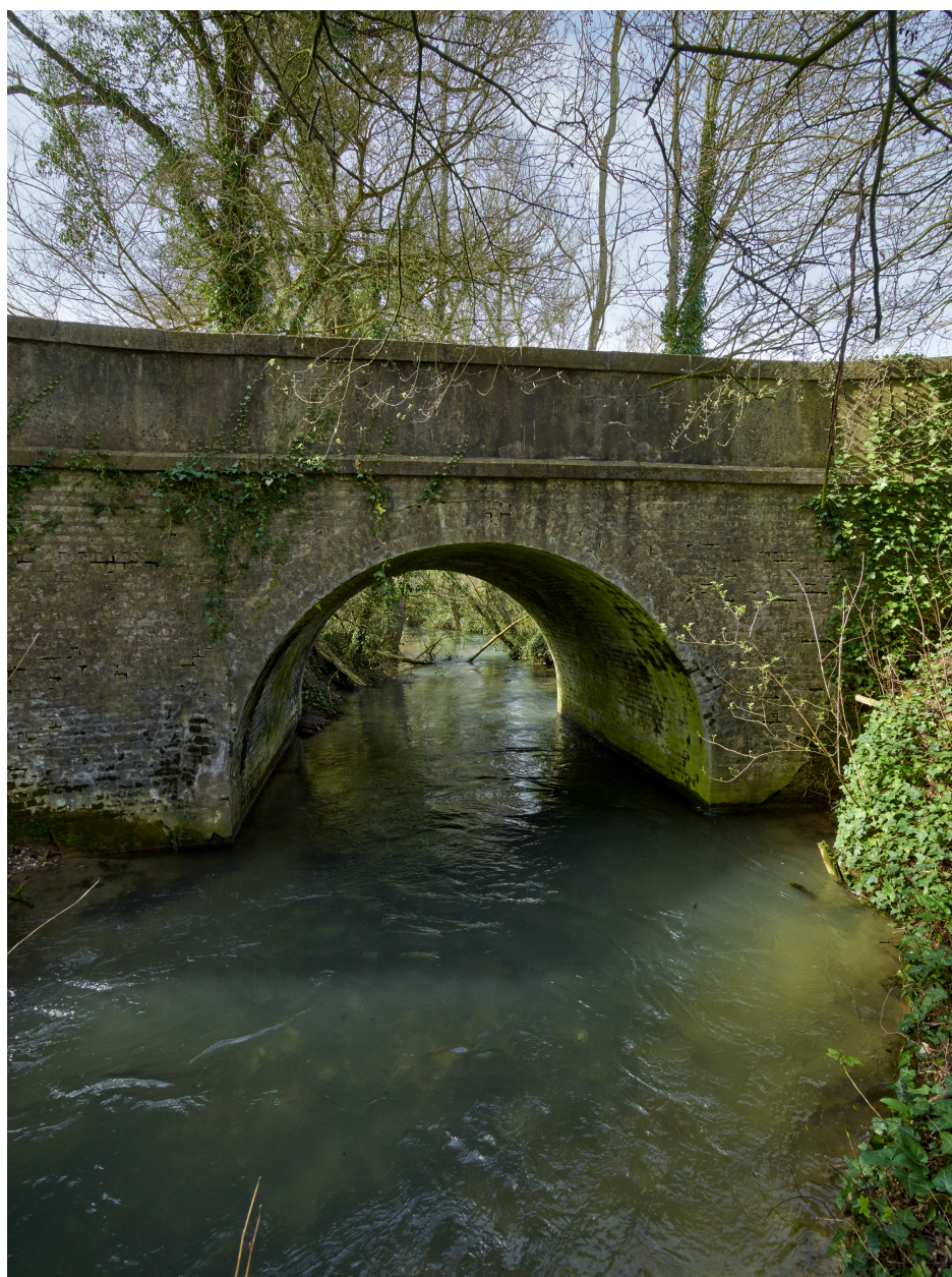
Vue du pont depuis l'est.
