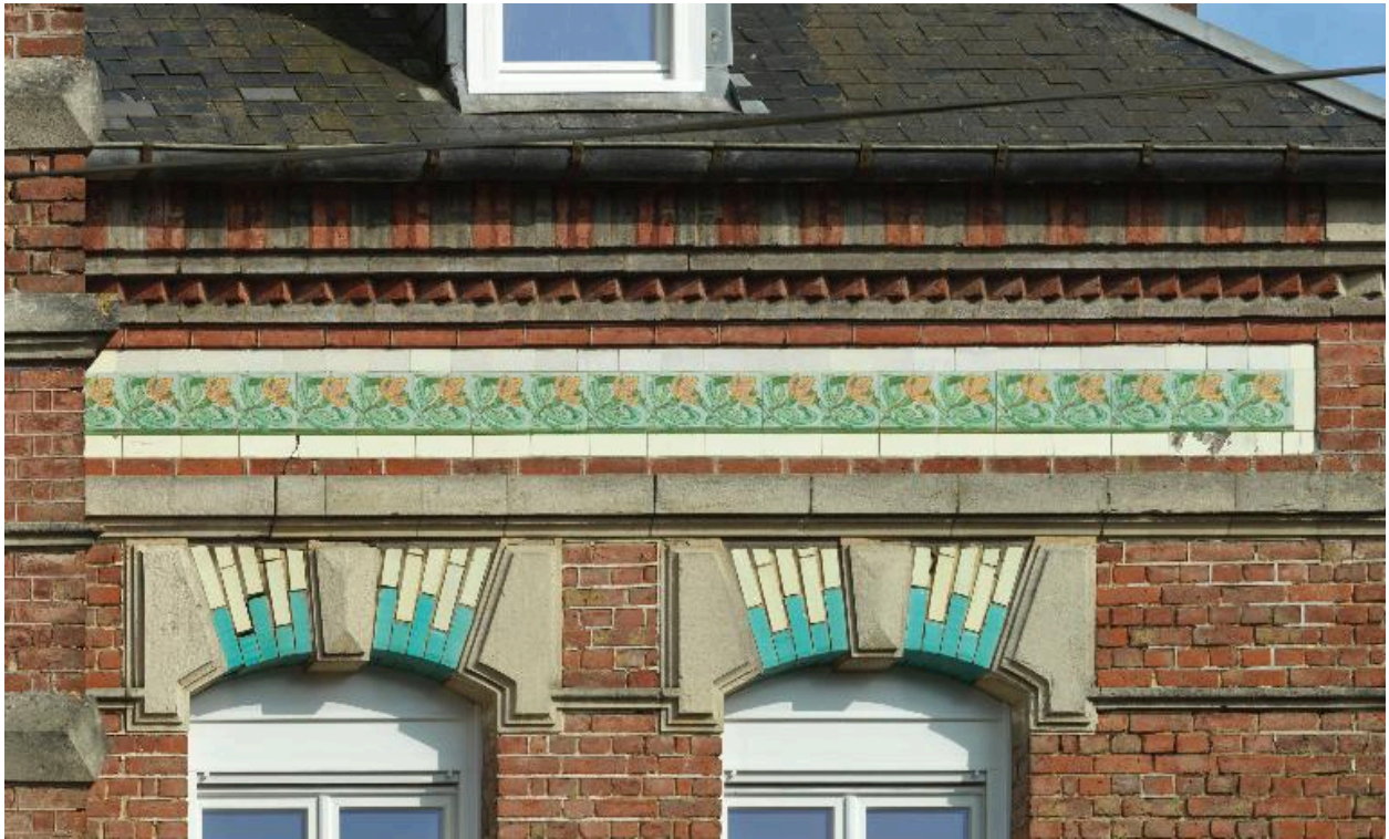
Détail de la frise à motifs floraux en carreaux vernissés au sommet de la façade sur cour.
