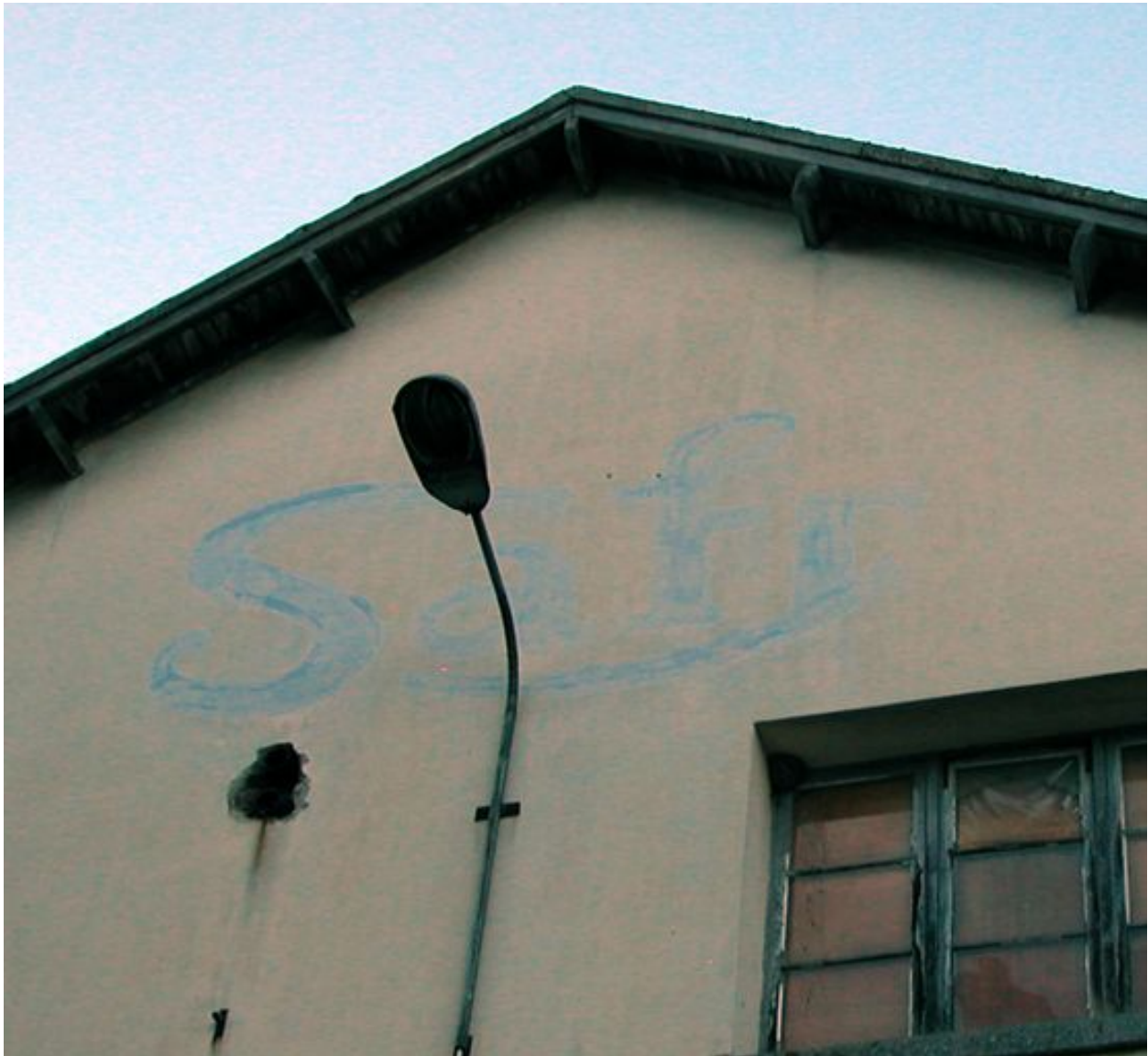
Détail de l'enseigne de l'entreprise SAFR, peinte sur le pignon de l'atelier de fabrication.
