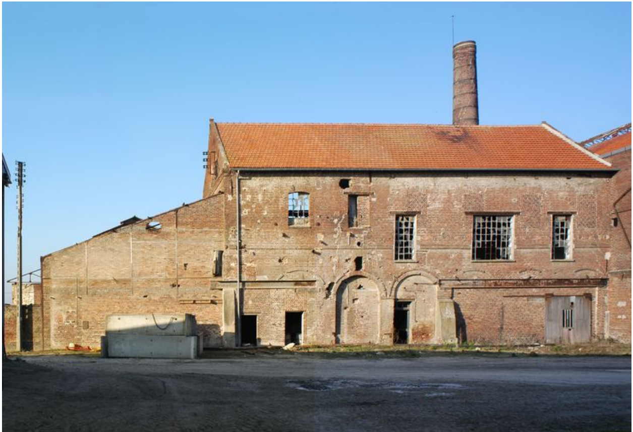
Façade arrière (est) de l'atelier de fabrication
